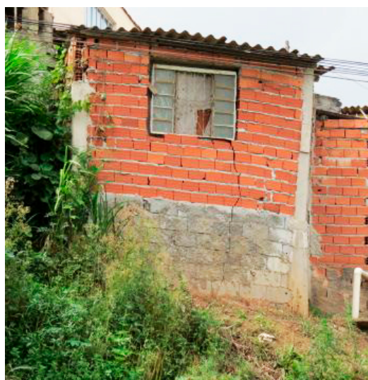
Figura 6. Trinca em edificação próxima da quebra do relevo. Fonte: LabGRis, 2020.
