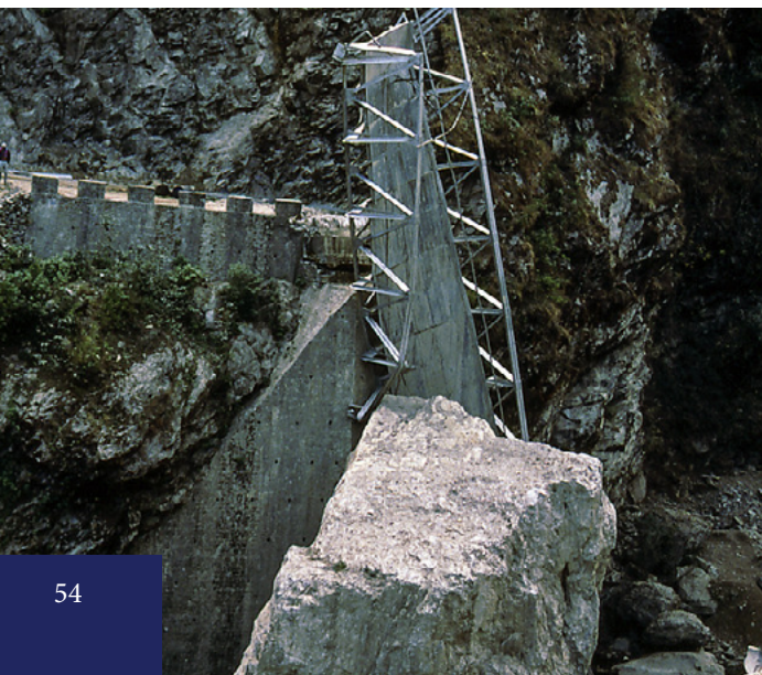
Figura 3. Quedas e rolamentos de blocos rochosos. Foto: “Rock fall near Dhunche, Nepal, 1988”, Fonte: NettyA (Licença CC BY-NC-ND 2.0).
