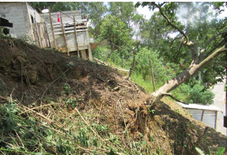
Figura 10. Árvores inclinadas, degrau de abatemento e material deslocado por deslizamentos. Fonte: LabGRis, 2020.
