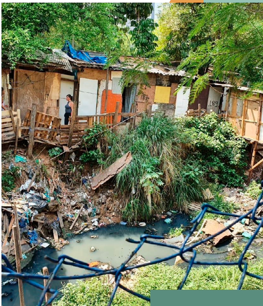
Figura 16. Precariedade e ausência de saneamento ambiental na região central da cidade mais rica do país: favela da Rua Quirino dos Santos, no bairro da Barra Funda, em São Paulo. Fonte: Leonardo S.S. Varallo, 2020.
